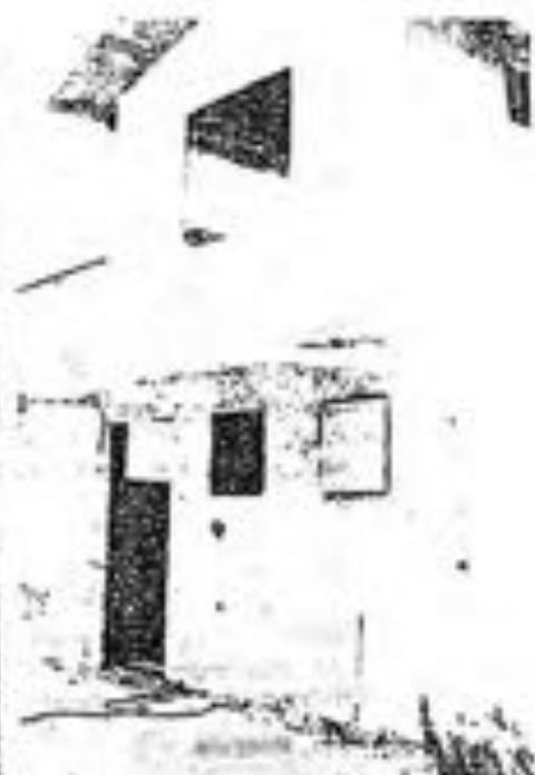
Con ferrocemento (como el empleado para construir embarcaciones), han edificado un grupo inicial de 6 casas como éstas, en Cárdenas, provincia de Matanzas.
