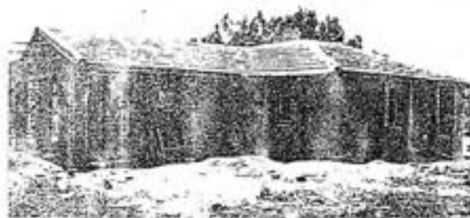
Con ferrocemento (como el empleado para construir embarcaciones), han edificado un grupo inicial de 6 casas como éstas, en Cárdenas, provincia de Matanzas.
